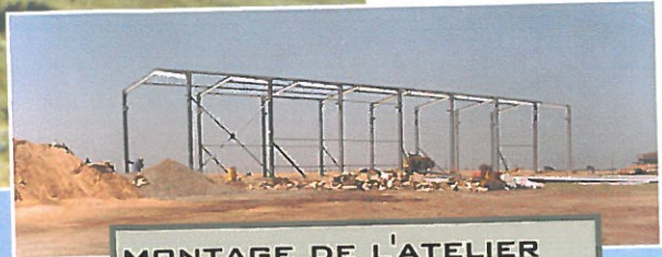
MONTAGE DE L'ATELIER MÉCANIQUE
