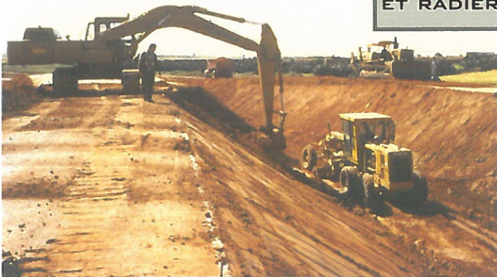
FINITION DES TALUS ET RADIER
