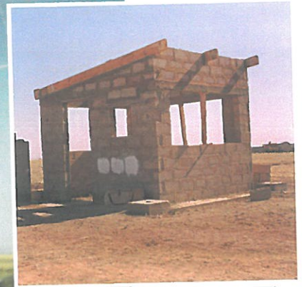
POSTE DE GARDE
