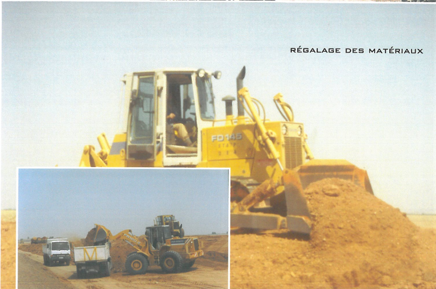
CHARGEMENT ET MISE EN PLACE DES MATÉRIEAUX
