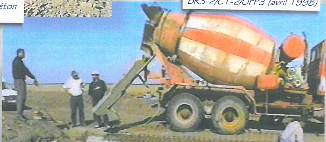
Bétonnage - ouvrage type OFP-SM BR3-2/C1-2/OFP3 (avril 1998)
