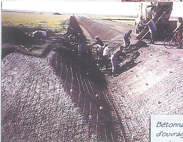
Bétonnage de revêtement d'ouvrage OFP
