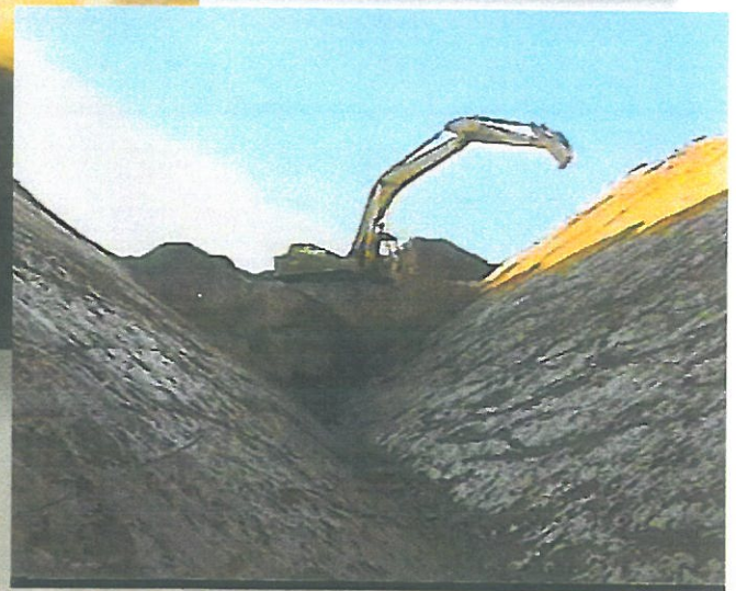
terrassement de colature C1-1-Cex du secteur BR1-1 (oct. 1999)
