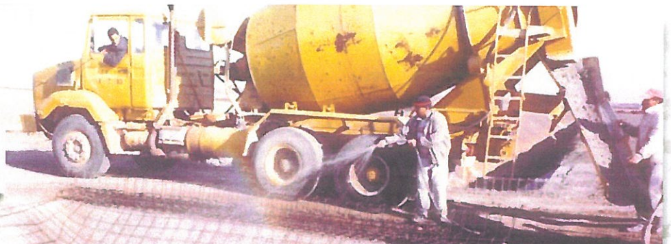
Humidification du support avant bétonnage
