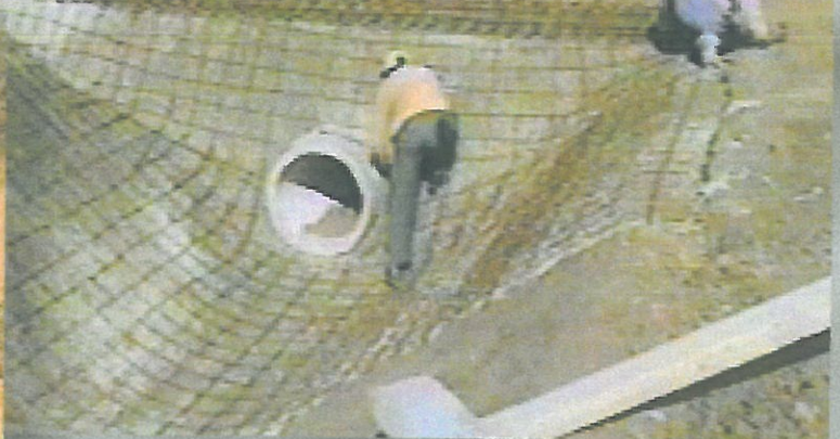
Mise en place et pervibration de béton 300 Ouvrage chute BR1-1/C9/CH3 (sept. 1999)
